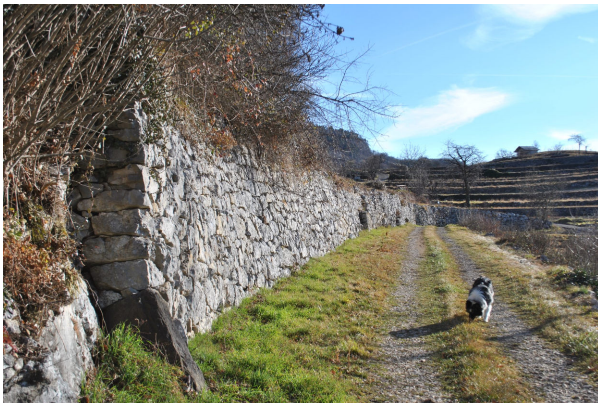
In primo piano un masso di origine vulcanica usato alla base del muro realizzato con pietre calcaree, Nomesino (©2020 Alessio Maggiani)
