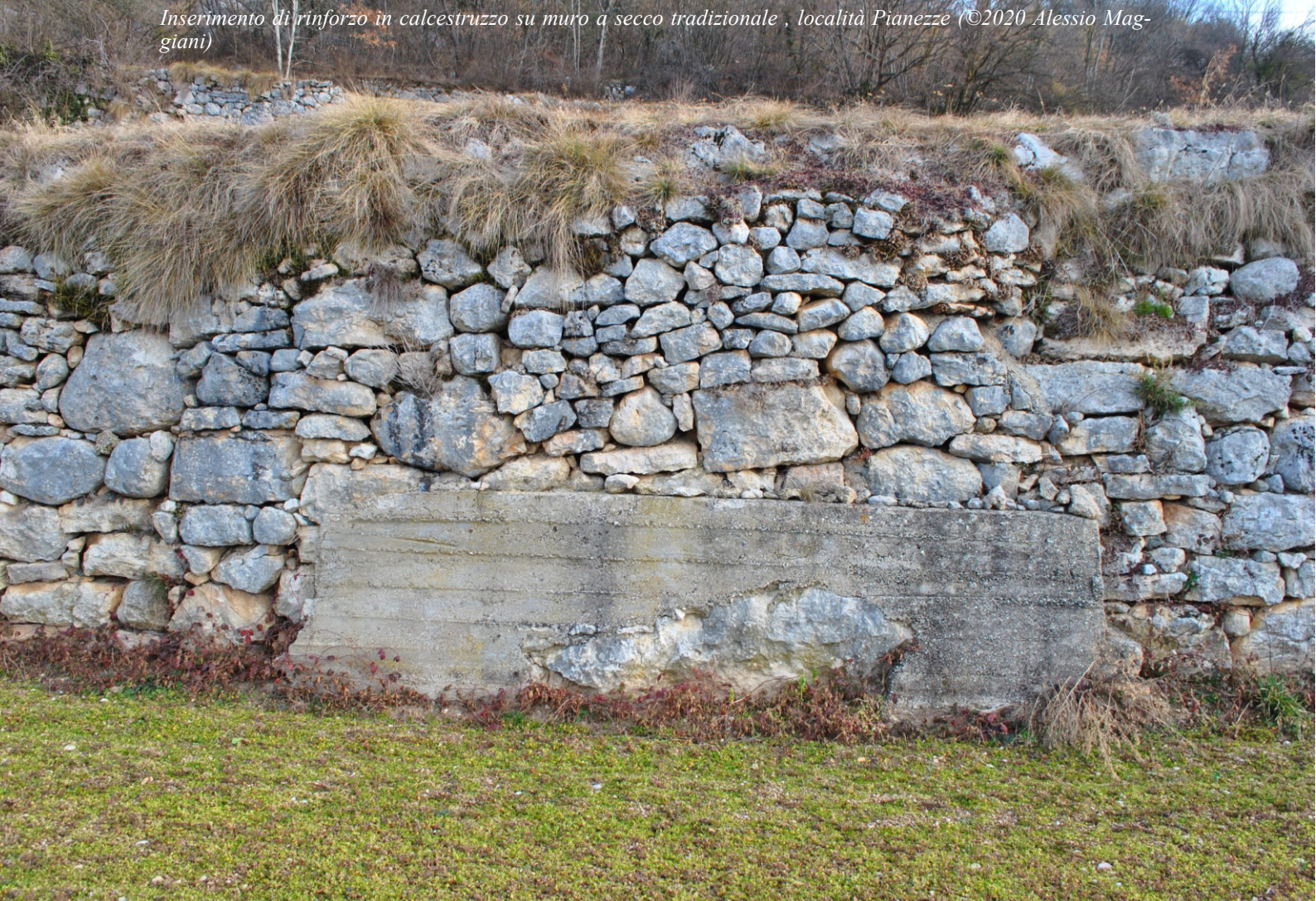
Ricostruzione di una porzione di muro a secco con tecniche e materiali non tradizionali, località Pianezze (©2020 Alessio Maggiani)
