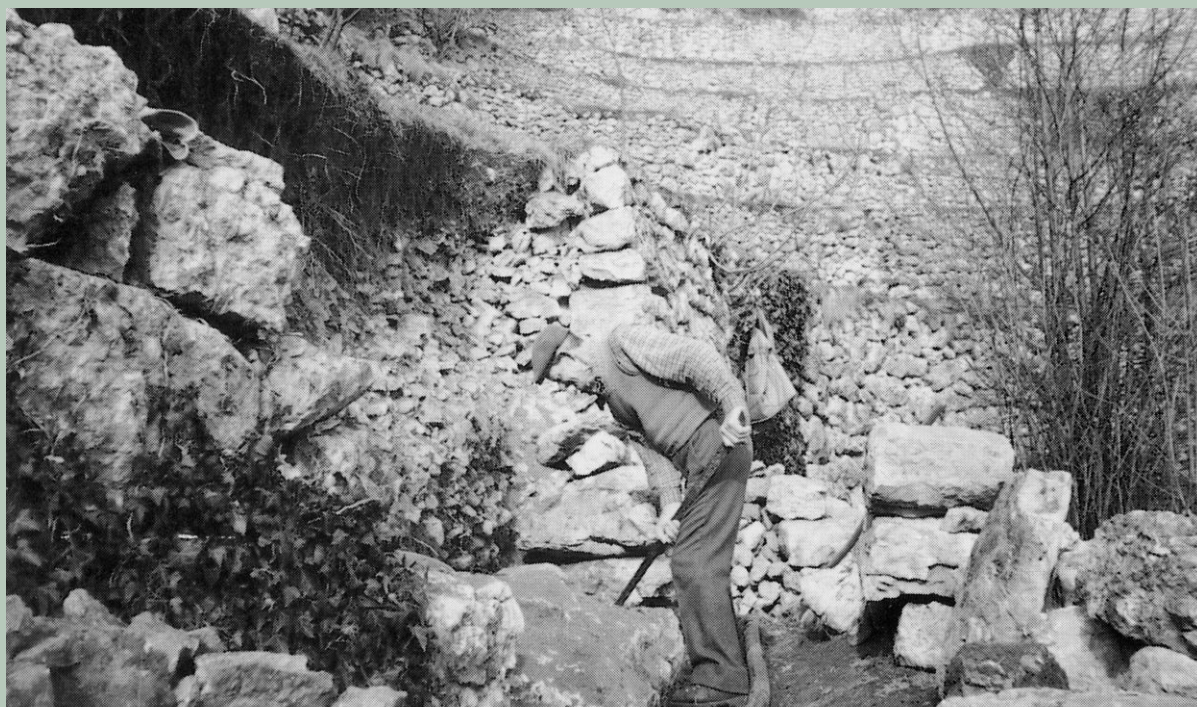
Federico Benoni al lavoro nella ricostruzione di un muro a secco in località Busóm a Valle San Felice, in Benoni G., Muri e sgrebene, cit., p.85
